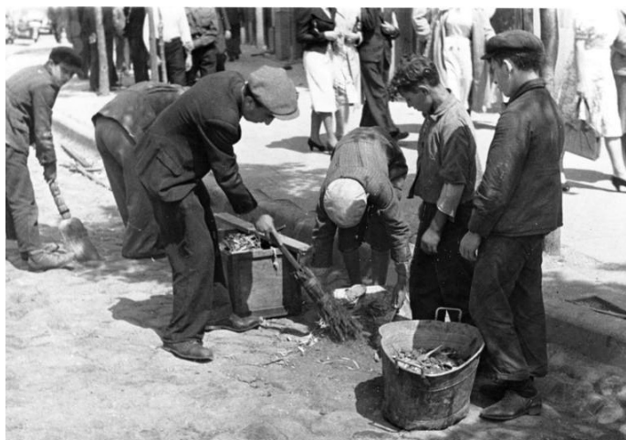
Judeus durante trabalhos forçados em obras públicas. Białystok, 20.6.1941.
